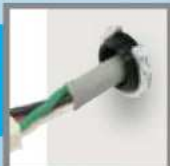
ロックナットを電線に通し ニップルを固定する
